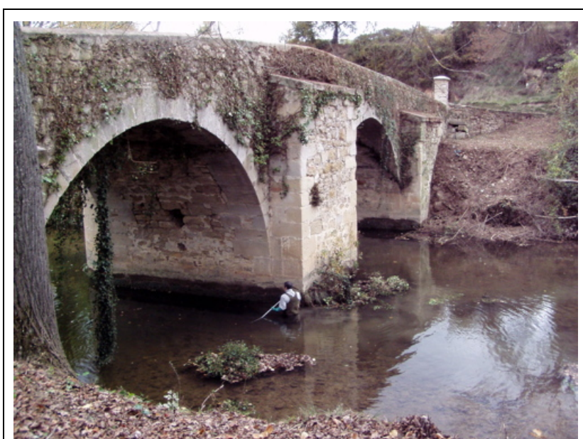
Zona O-1 (estación OM-244, Venta Blanca)
